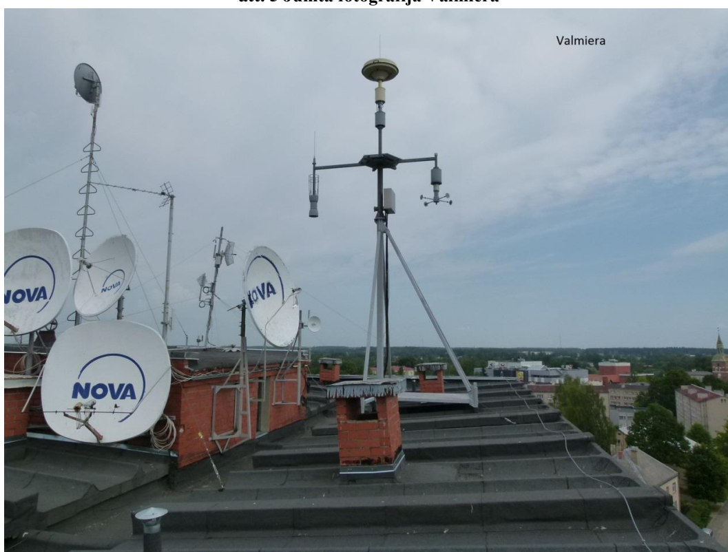
att. 6 Jumta fotogrāfija Valmierā
