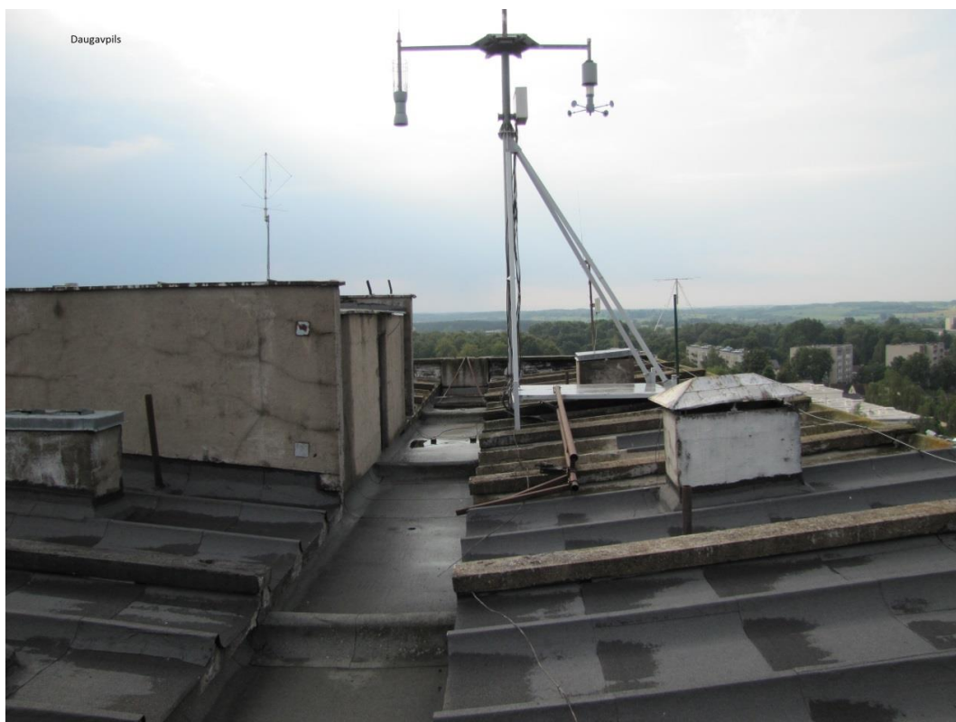
att. 7 Jumta fotogrāfija Daugavpilī
