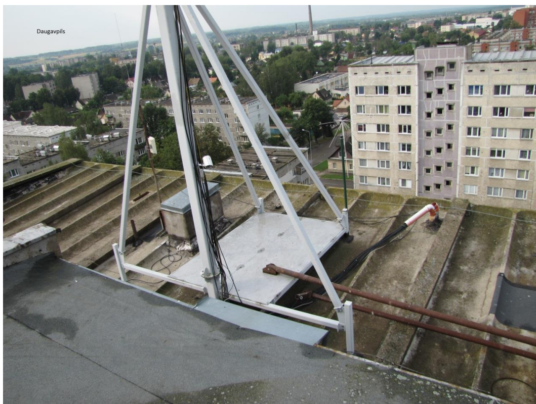
att. 9 Jumta fotogrāfija Daugavpilī
