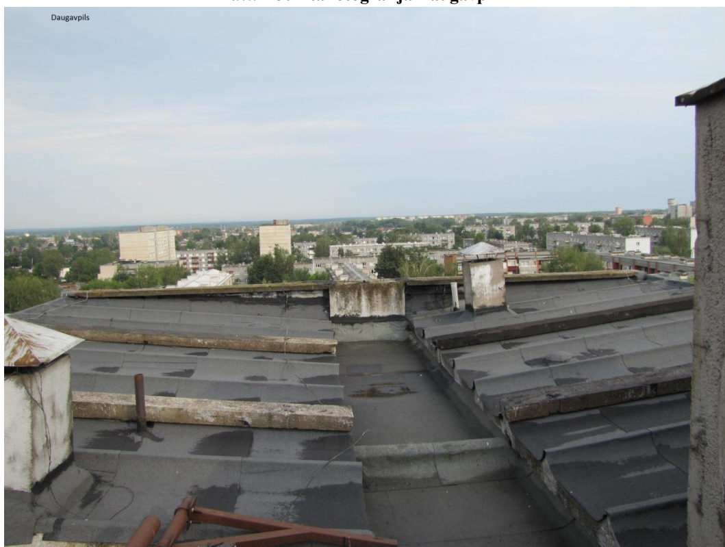
att. 8 Jumta fotogrāfija Daugavpilī
