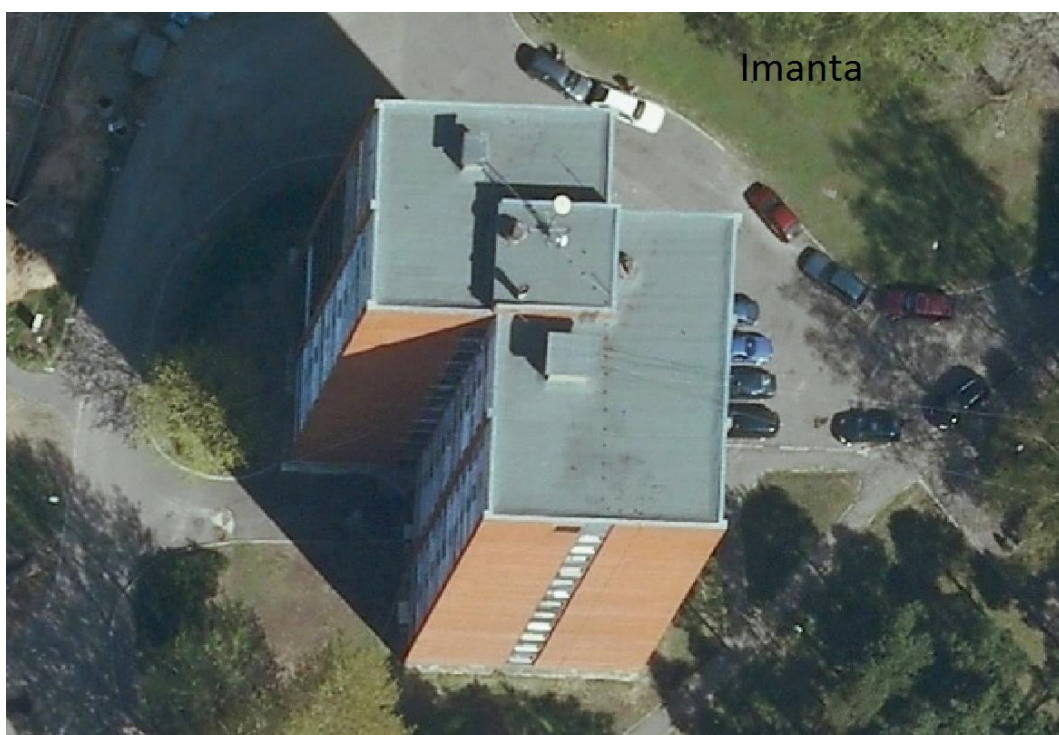
att. 10 Jumta fotogrāfija Slokas 171, Rīgā
